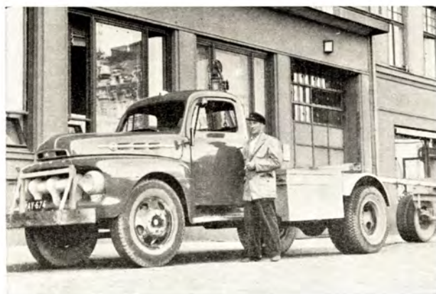
Pylväänkuljetusauto. Vau- nussa on kuormausnosturi
