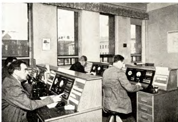
Vikakonttorin koepöydät. Vikailmoituksen perusteella tapahtuu vianetsintä ensi vai- heessa näiden laitteiden avulla
