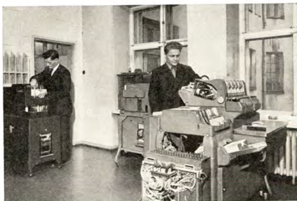
Reikäkorttikoneita. Laskutus ja monet tilastotehtävät su- oritetaan koneellisesti reikä- korttimenettelmällä
