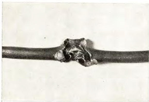
Salaman jälki ilmakaapelissa
