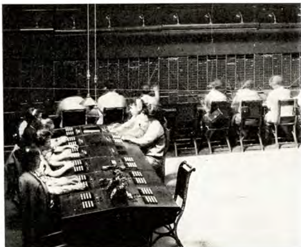
Välityspaikka käsikeskuksesta automaattikeskuksiin
