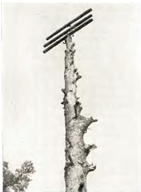
Lunastetuissa maaseutulaitoksissa olivat johtoverkot usein heikossa kunnossa: — tässä kuivunut honka puhelinpylväänä
