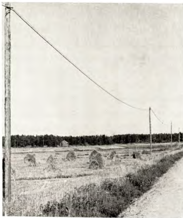
Maaseutulaitoksissa kunnostetaan ensin johtoverkko: sokea ilmakaapeli avojohtorykelmien tilalle —
