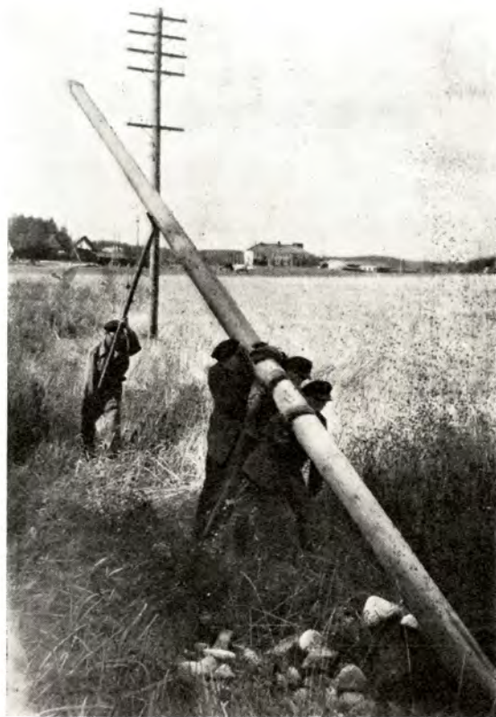
Hartiavoimat ovat yhä tarpeen: pylvään pystytystä 1950-luvulla
