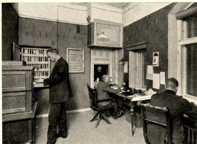
(S. H.) LINJARAKENNUSOSASTON TOIMITUSHUONE
